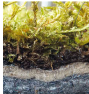
Foto: Aufbau der Moosmatten (©Vertiko GmbH)
