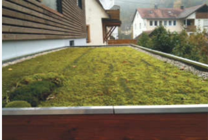
Foto: Moosdachbegrünung mit kultivierten Moosmatten als Fertigware (iVVertiko GmbH)
