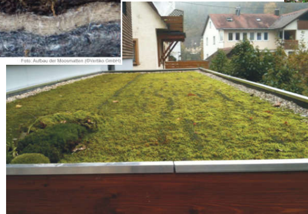
Foto: Moosdachbegrünung mit kultivierten Moosmatten als Fertigware (©Vertiko GmbH)
