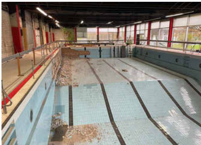
Der Umbau des Dora-Rau-Bads ist nur möglich, weil die Stadt Waderne eine Förderung von drei Millionen Euro vom Bund bekommt. Die Sanierung startete im November.
