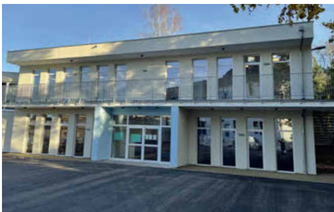
In Nunkirchen wurde die komplette Schule einer „Frischzellenkur“ unterzogen. Im größten Stadtteil entstand zudem ein komplett neues Gebäude für die FGTS.
