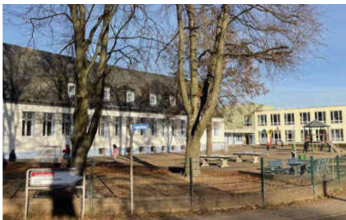
Auch die Gebäude bzw. Räume am größten Grundschulstandort Lockweiler wurden umfassenden Sanierungsmaßnahmen unterzogen.
