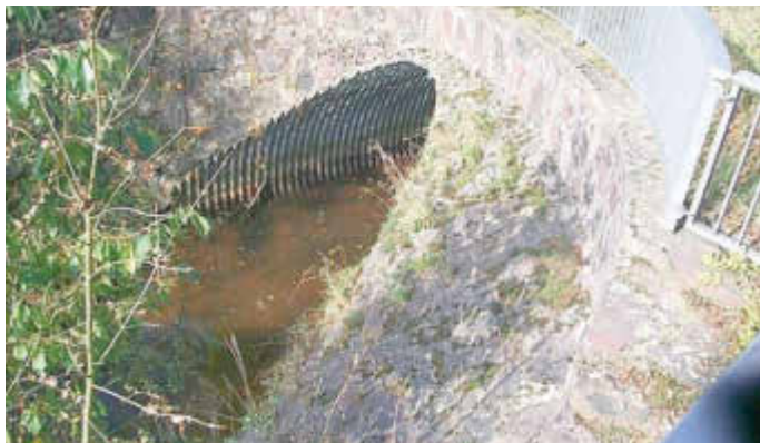
Ansicht Unterlauf (Auslaufseite)
